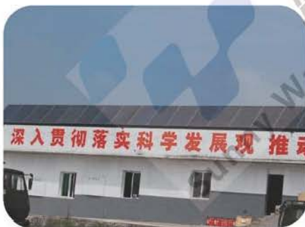
四川绵阳某部队生活热水系统
