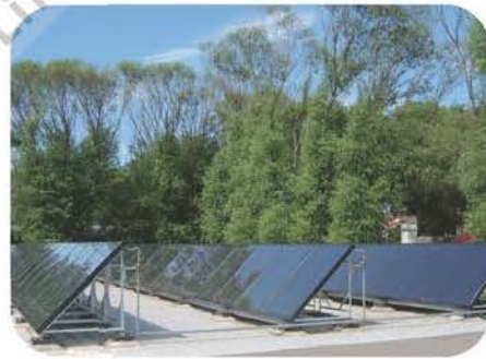
北京某马场采暖/生活热水供热系统
