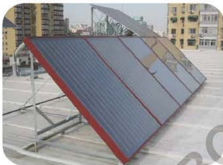
北京市节能中心开水预热系统
